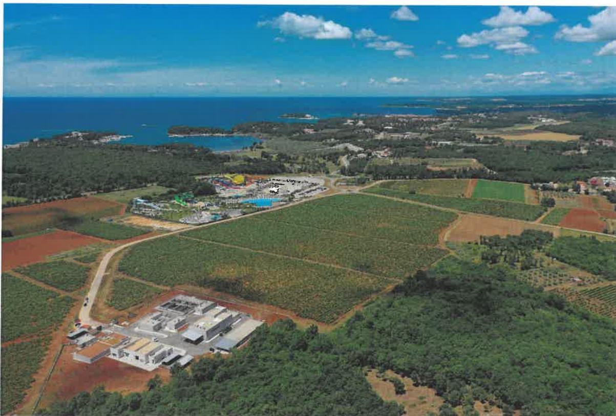
Slika 3. Uređaj za pročišćavanje otpadnih voda Poreč Jug
