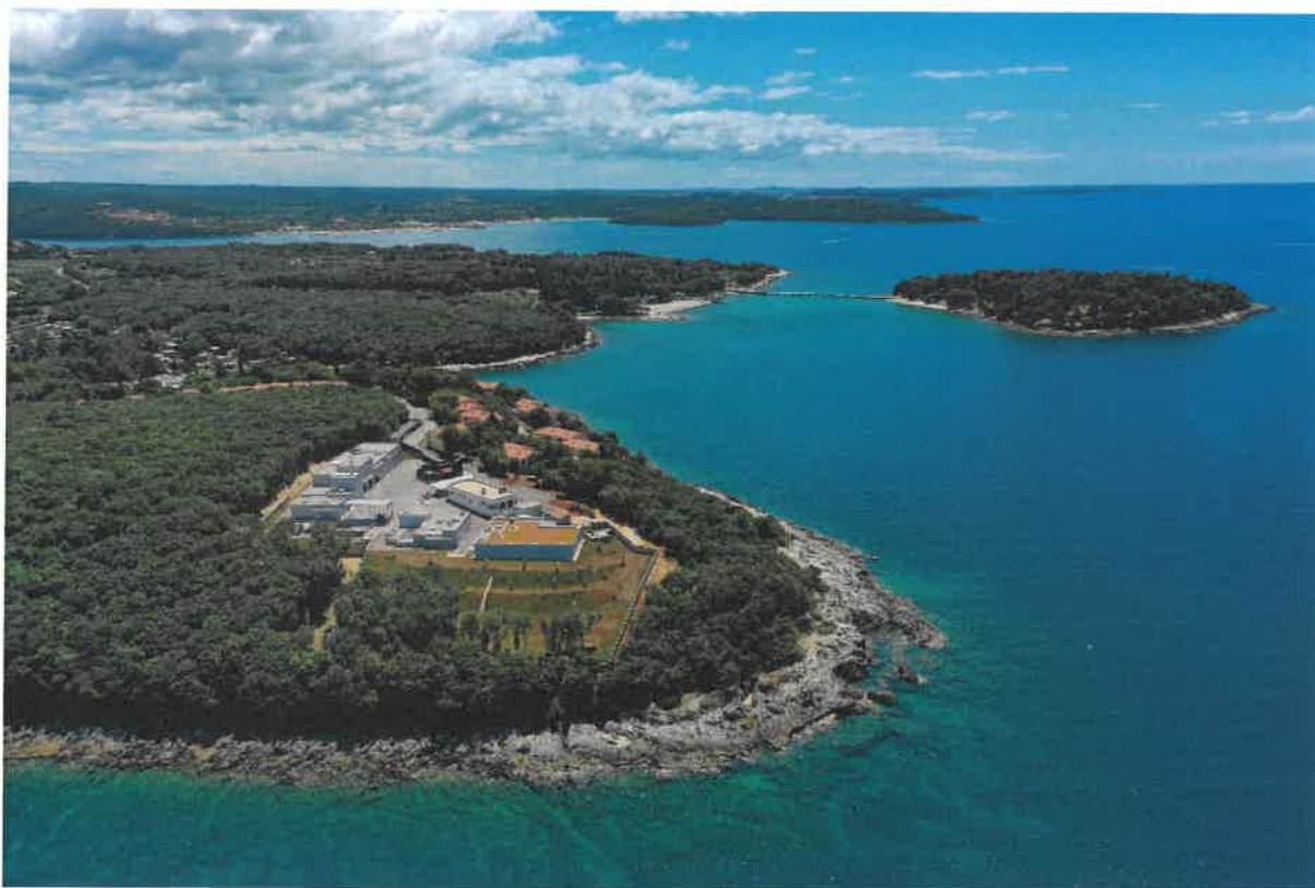
Slika 4. Uređaj za pročišćavanje otpadnih voda Vrsar
