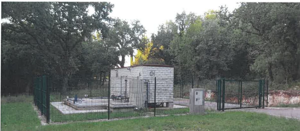
Slika 7. Uređaj za pročišćavanje otpadnih voda Kloštar
