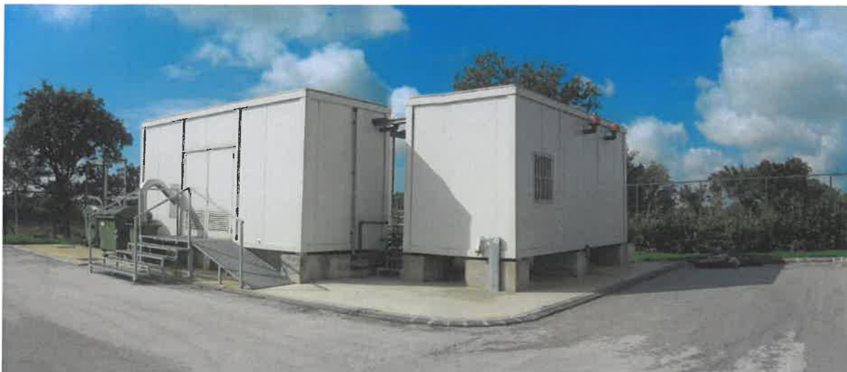
Slika 5. Uređaj za pročišćavanje otpadnih voda Sv. Lovreč
