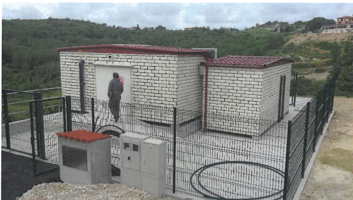
Slika 6. Uređaj za pročišćavanje otpadnih voda Vižinada
