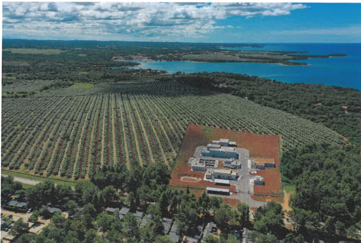
Slika 1. Uređaj za pročišćavanje otpadnih voda Lanterna
