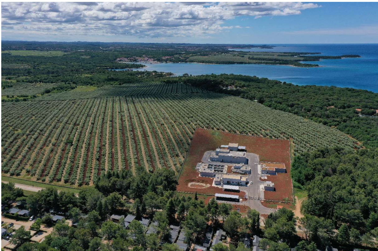
Slika 1. Uređaj za pročišćavanje otpadnih voda Lanterna
