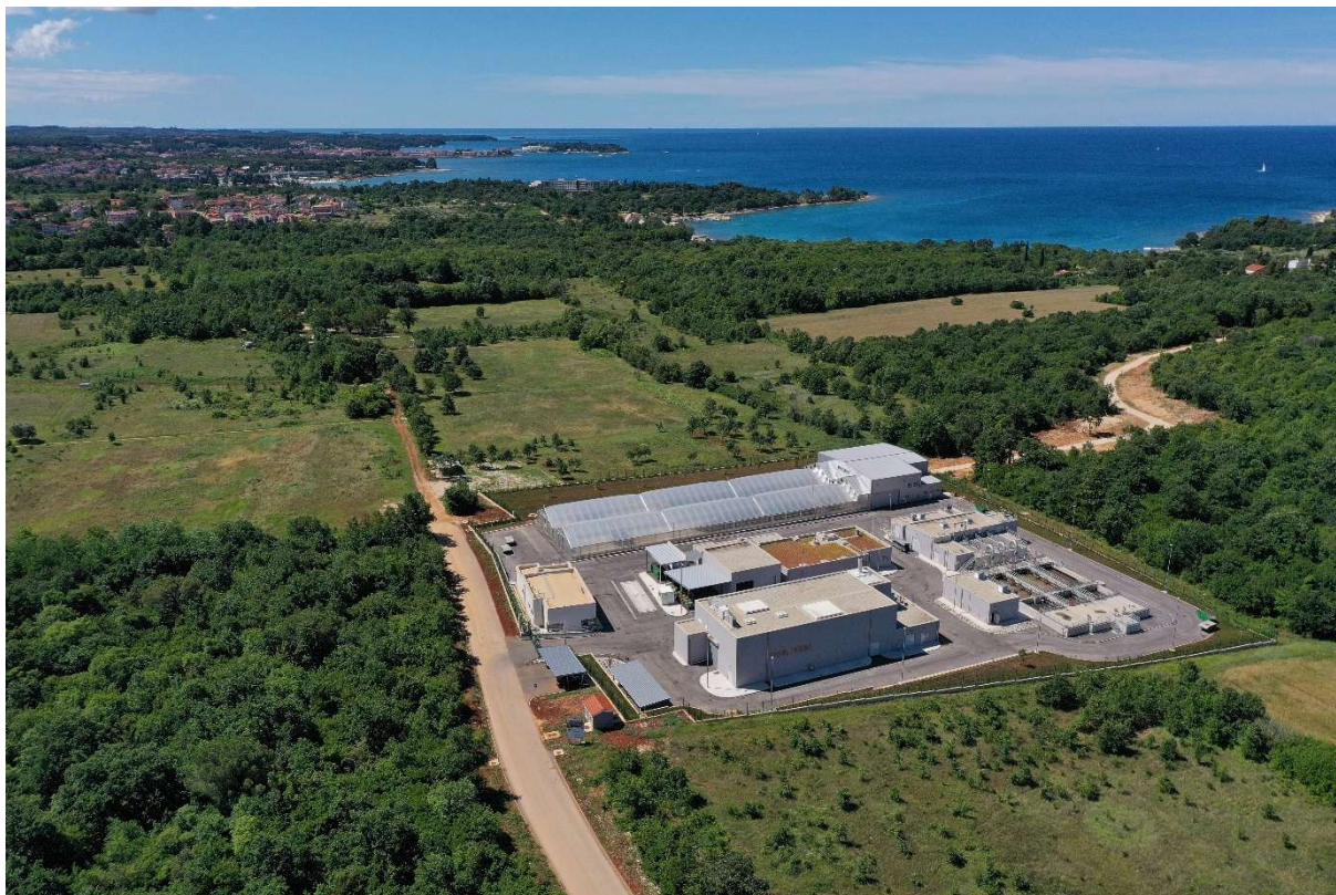
Slika 2. Uređaj za pročišćavanje otpadnih voda Poreč Sjever sa postrojenjem za solarno sušenje mulja
