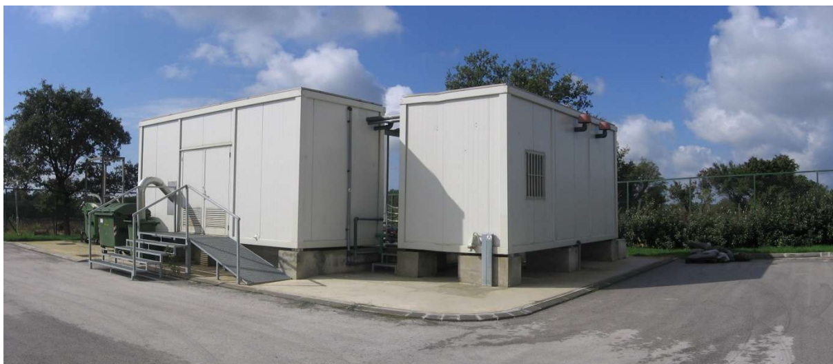
Slika 5. Uređaj za pročišćavanje otpadnih voda Sv. Lovreč
