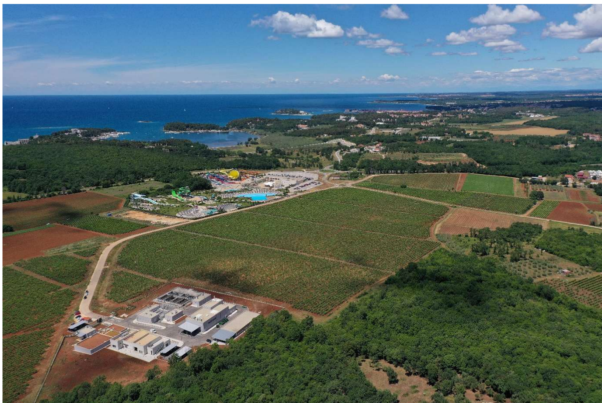
Slika 3. Uređaj za pročišćavanje otpadnih voda Poreč Jug
