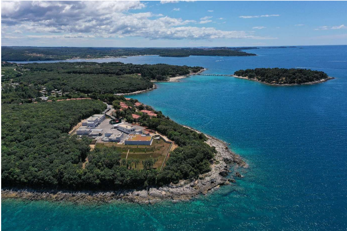
Slika 4. Uređaj za pročišćavanje otpadnih voda Vrsar
